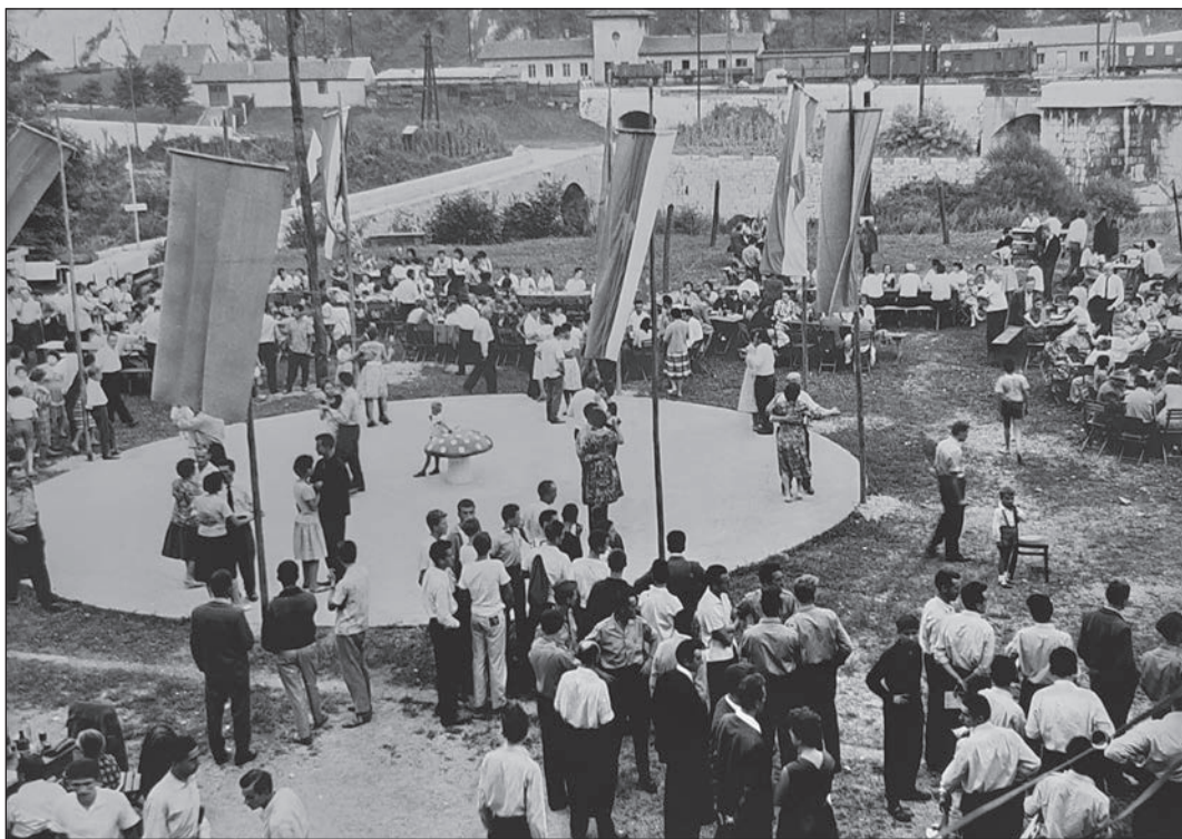
Veselica na prostoru porušene šole ob cestnem mostu v šesdesetih letih 20. stoletja. (arhiv C. Mladovan)
